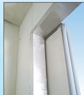
開口枠用ガード 台車やリフトの接触による破損防止用のガードです。
