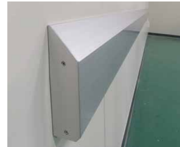
アルミ製台車ガード (端部塞ぎ材取り付け)
