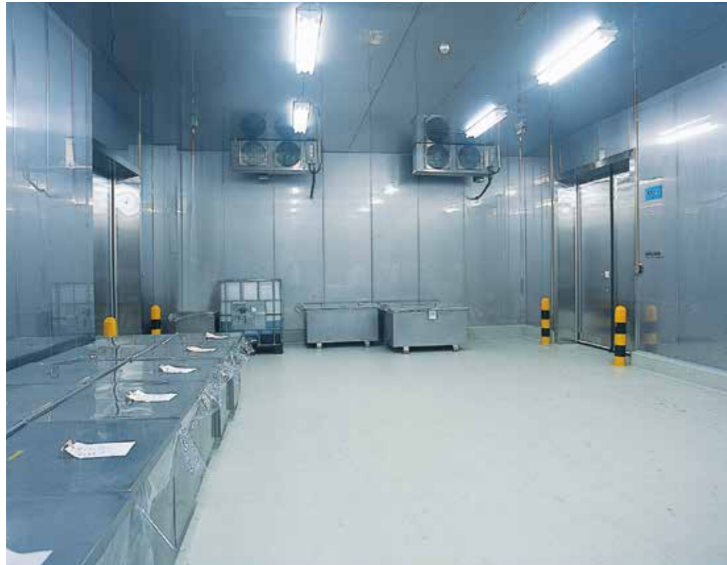
水産冷蔵倉庫
